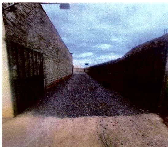
LATERAL DO IMÓVEL
