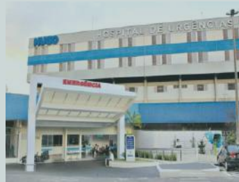
HOSPITAL DE URGÊNCIAS HUGO - GO
