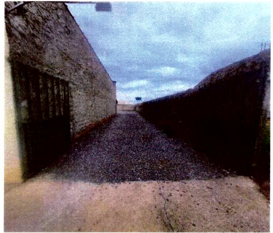
LATERAL DO IMÓVEL
