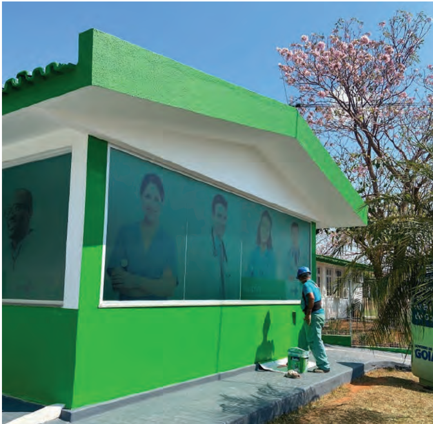
PINTURA EXTERNA DA UNIDADE FONTE: AUTOR
