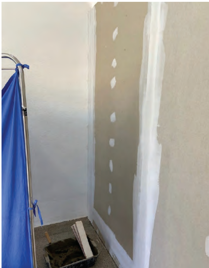
DIVISÓRIA CONSULTÓRIO OBSTÉTRICO E SALA DE EXAMES FONTE: AUTOR
