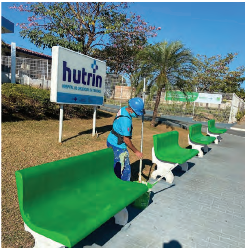
PINTURA DOS BANCOS DE CONCRETO FONTE: AUTOR
