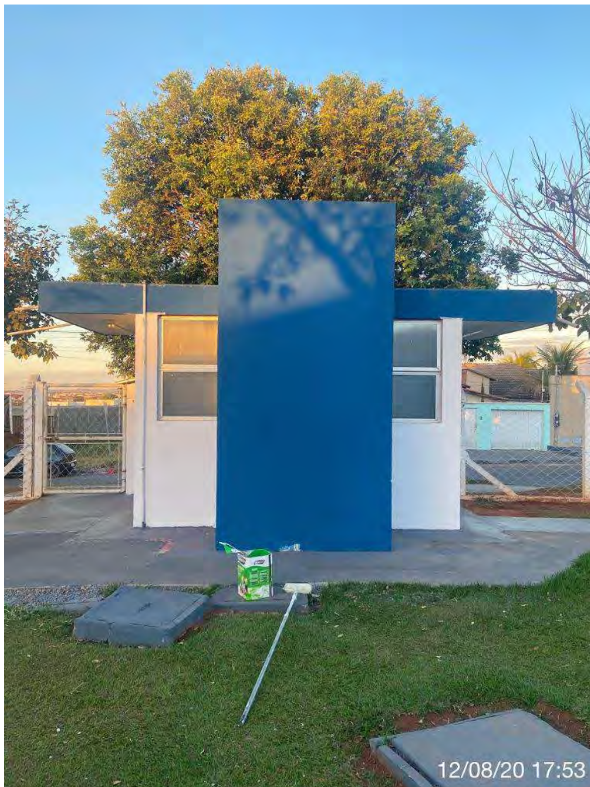
Vista da guarita antes da pintura
