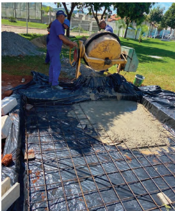
CONCRETAGEM DA BASE TANQUE DE OXIGÊNIO FONTE: AUTOR
