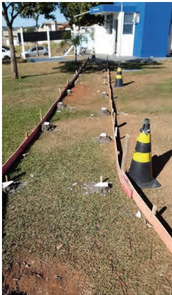
EXECUÇÃO DE CALÇADA PARA PASSAGEM DE GESTANTES FONTE: AUTOR
