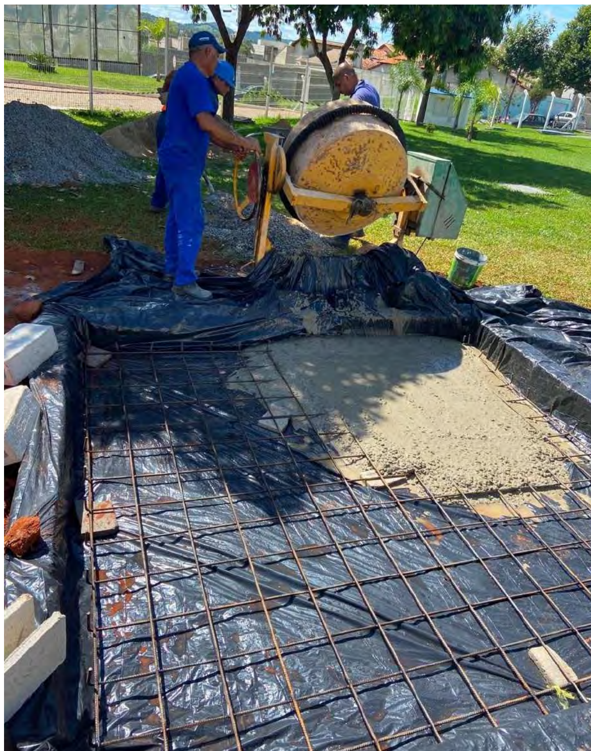
Concretagem da Base tanque de oxigênio
