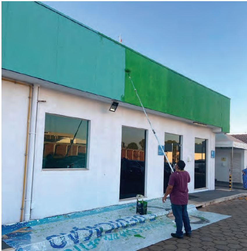
PINTURA EXTERNA DA UNIDADE FONTE: AUTOR
