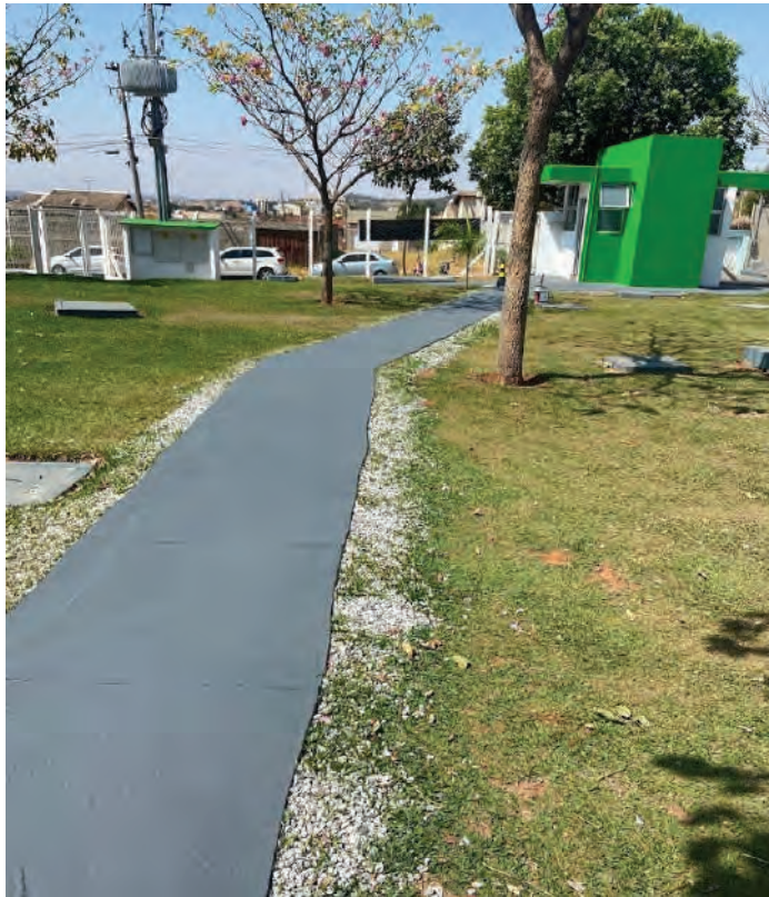
CALÇADA PARA PASSAGEM DE GESTANTES FONTE: AUTOR
