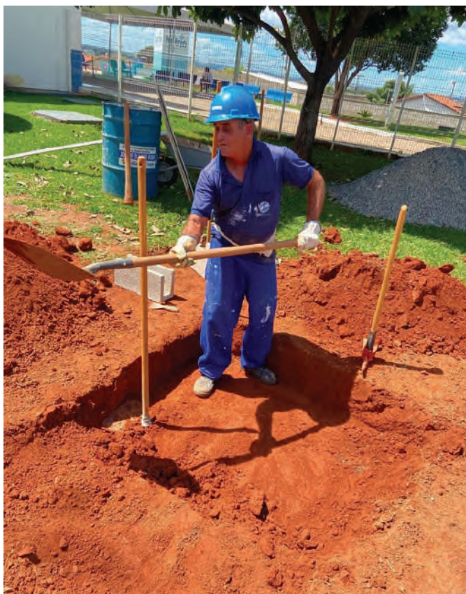
ESCAVAÇÃO PARA BASE TANQUE DE OXIGÊNIO FONTE: AUTOR
