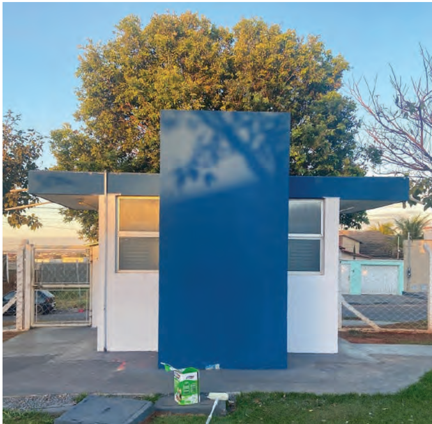
VISTA DA GUARITA ANTES DA PINTURA FONTE: AUTOR
