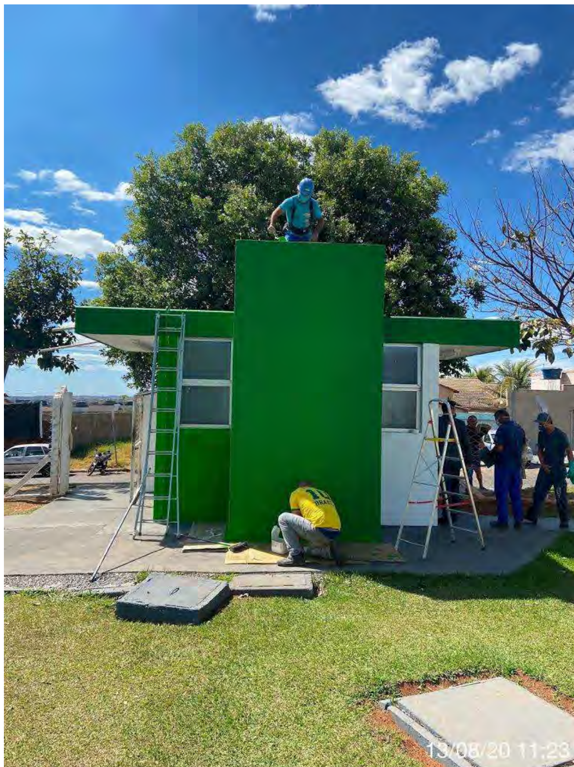
Vista da guarita após da pintura
