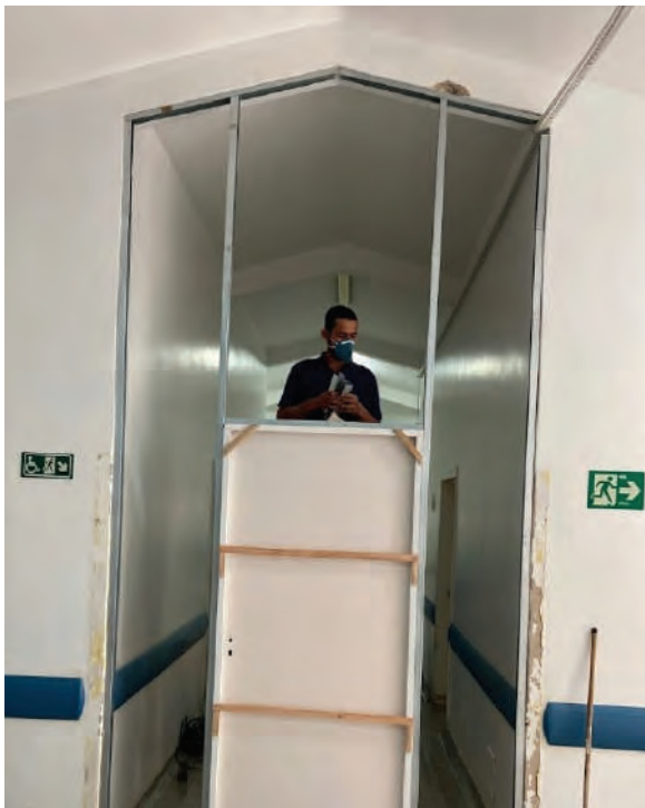
FECHAMENTO ÁREA DA UTI FONTE: AUTOR
